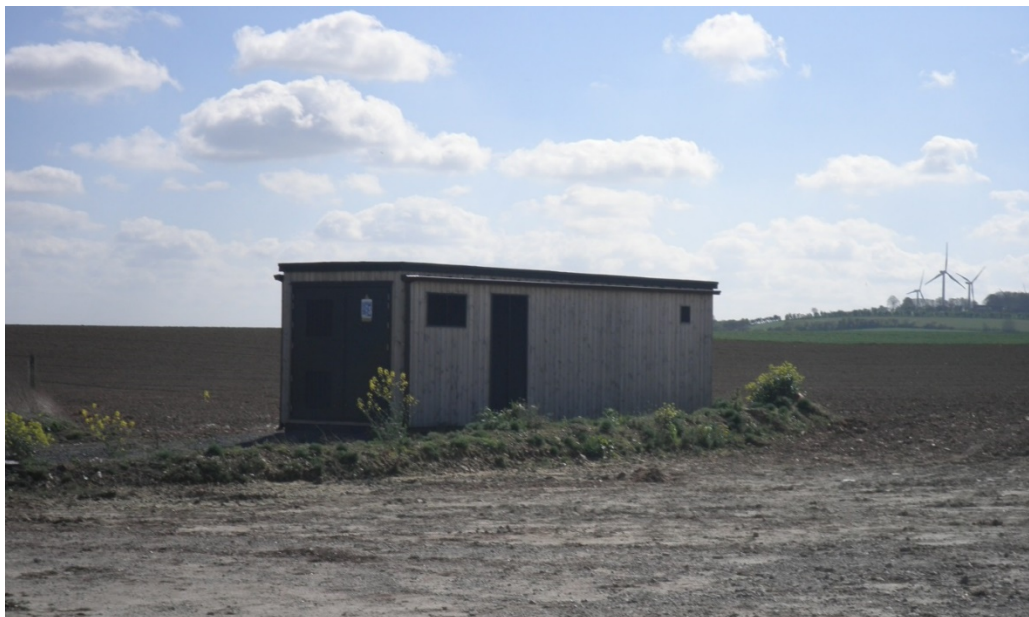
Figure 10 : Exemple du poste de livraison de la vallée de l'Aa (source : VALECO, 2017)
